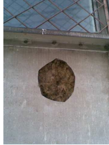
Foto. 3.6. Elewacja warstwowa (szkło hartowane, pustka powietrzna, płyta azbestowo-cementowa, wełna mineralna) (Ministerstwo Gospodarki, 2007)
