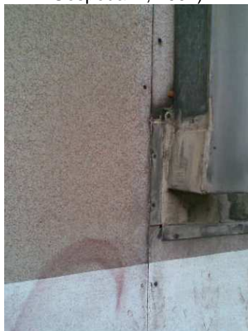
Foto. 3.9. Elewacja z płyty azbestowo-cementowej - prasowana płaska okładzinowa (Ministerstwo Gospodarki, 2007)
