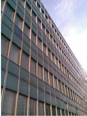
Foto. 3.5. Elewacja warstwowa (szkło hartowane, pustka powietrzna, płyta azbestowo-cementowa, wełna mineralna) (Ministerstwo Gospodarki, 2007)
