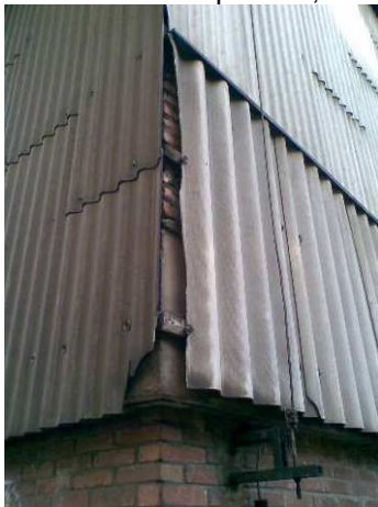
Foto. 3.7. Elewacja z płyty falistej, płyty azbestowo-cementowej (Ministerstwo Gospodarki, 2007)
