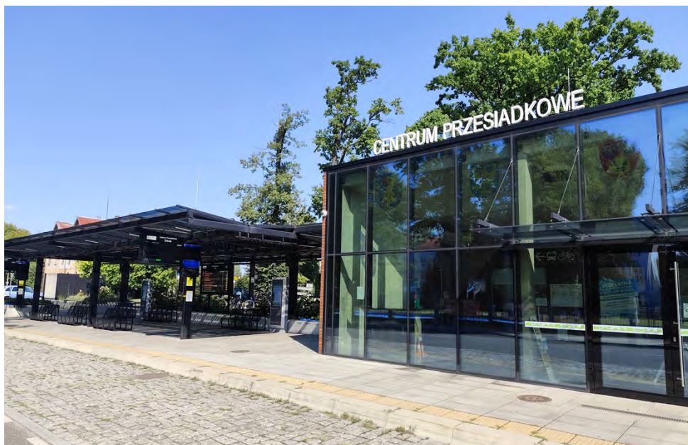
Rys. 19 Punkt obsługi pasażerów pszczyńskiej komunikacji powiatowej
