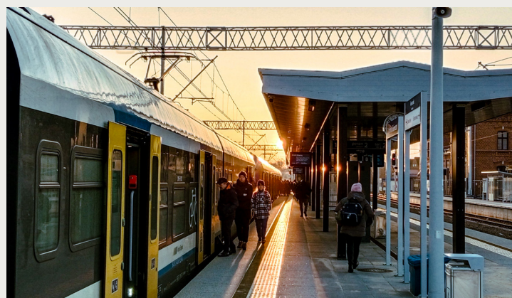
Fot. 10 Peron stacji Dąbrowa Górnicza, fot. Marcin Domański.
