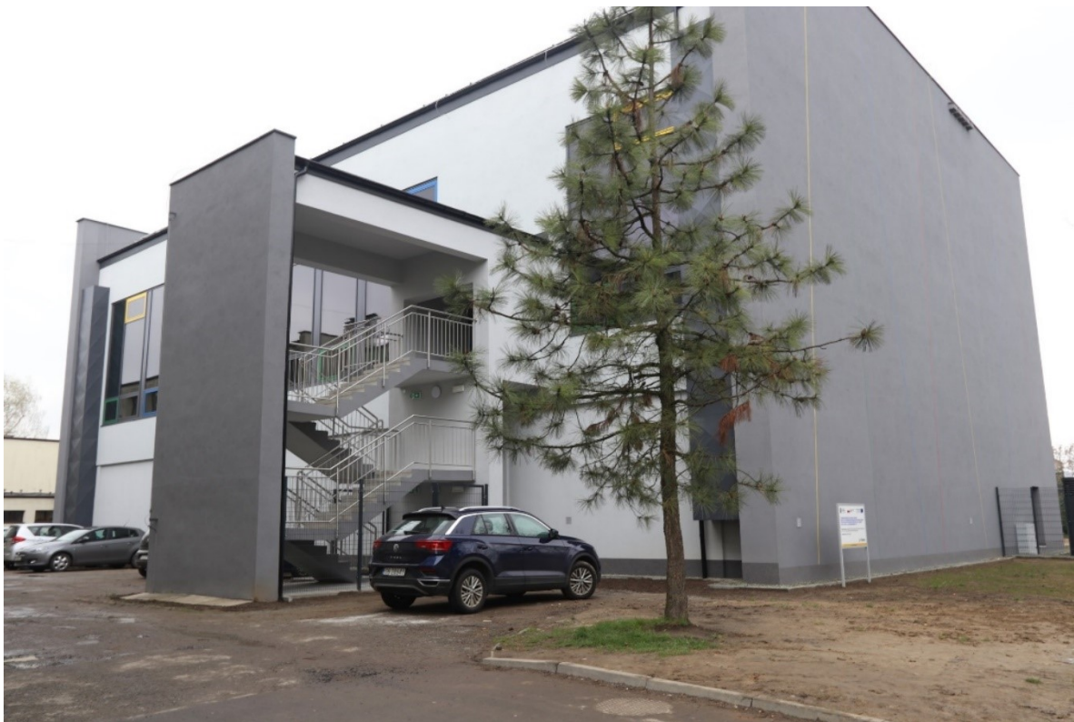
Zdjęcie 4. Budynek basenu po termomodernizacji
