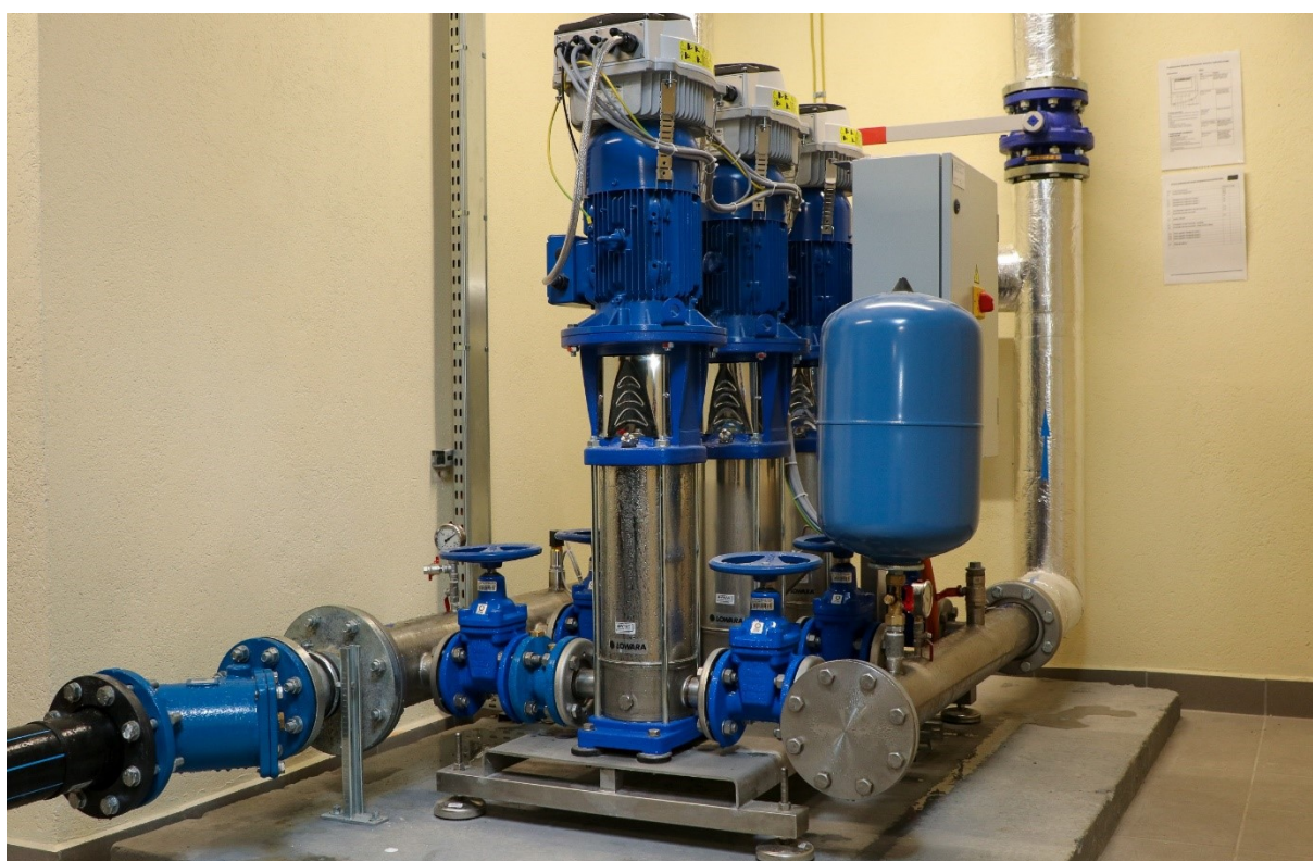
Zdjęcie 9. Modernizacja instalacji wodociągowej w budynku szpitala.
