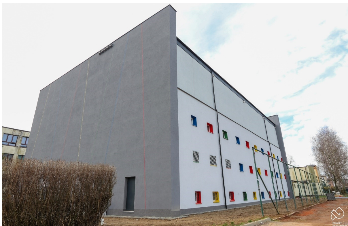
Zdjęcie 7. Termomodernizacja budynku basenu przy PZS nr 2 w Pszczynie.
