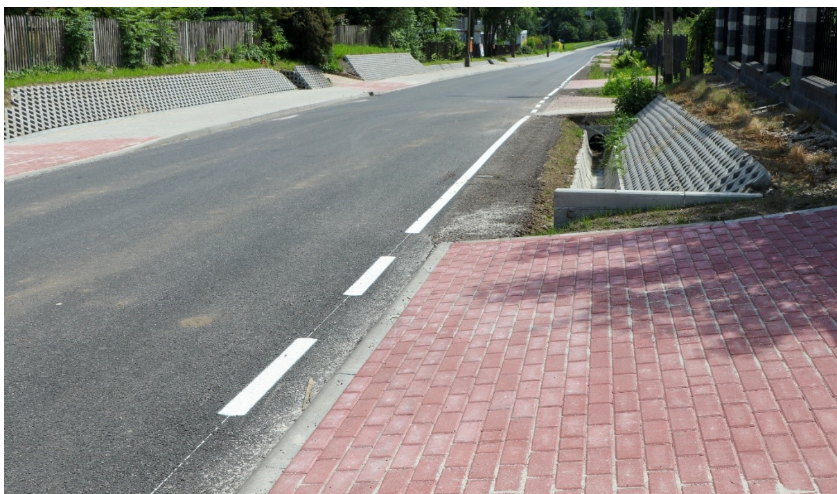
Zdjęcie 10. Przebudowa ul. Szkolnej w Porębie i Porębskiej w Radostowicach.
