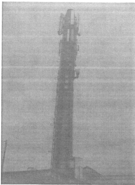
Zoł. nr 1: Widok ogólny instalacji radiokomunikacyjnej.
