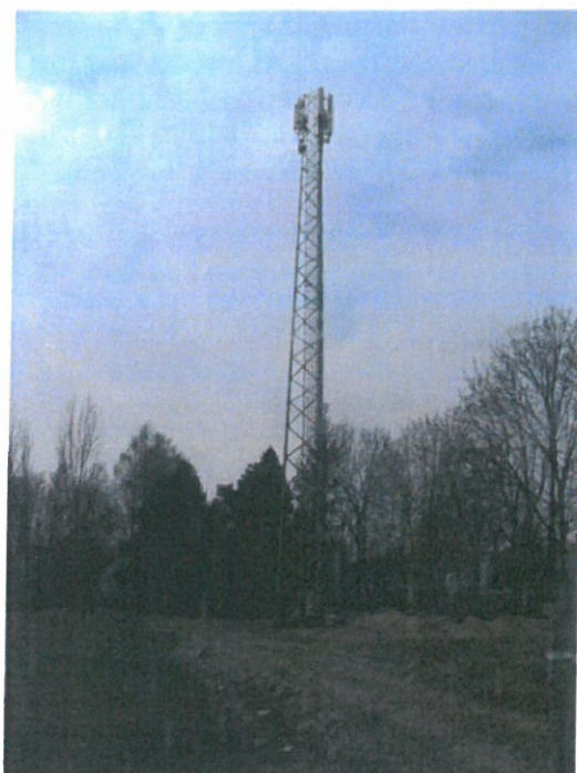
Zał. nr 1: Widok ogólny instalacji radiokomunikacyjnej.
